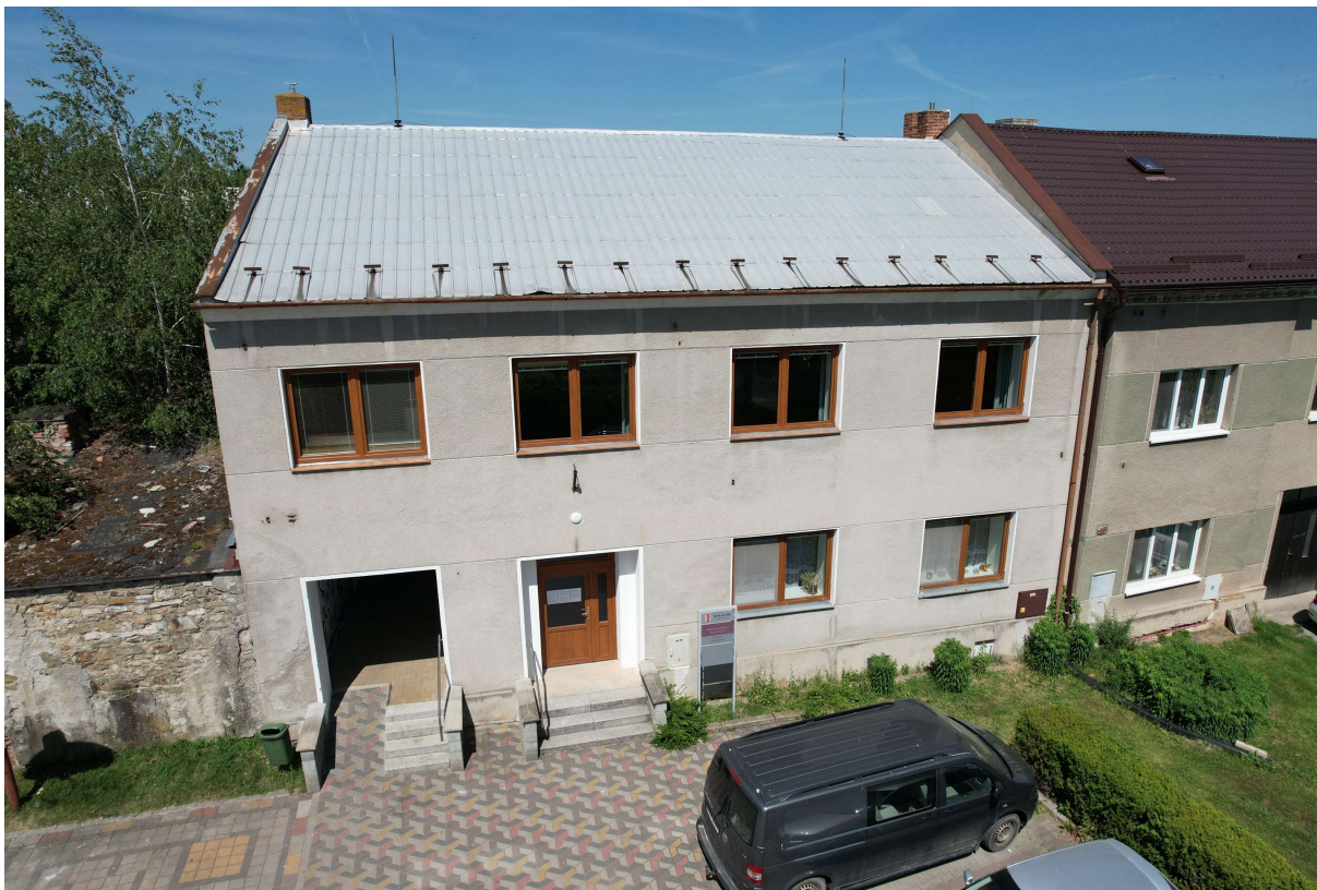
Obrázek č. 2.6.32: Dům služeb – fotodokumentace z místního šetření
