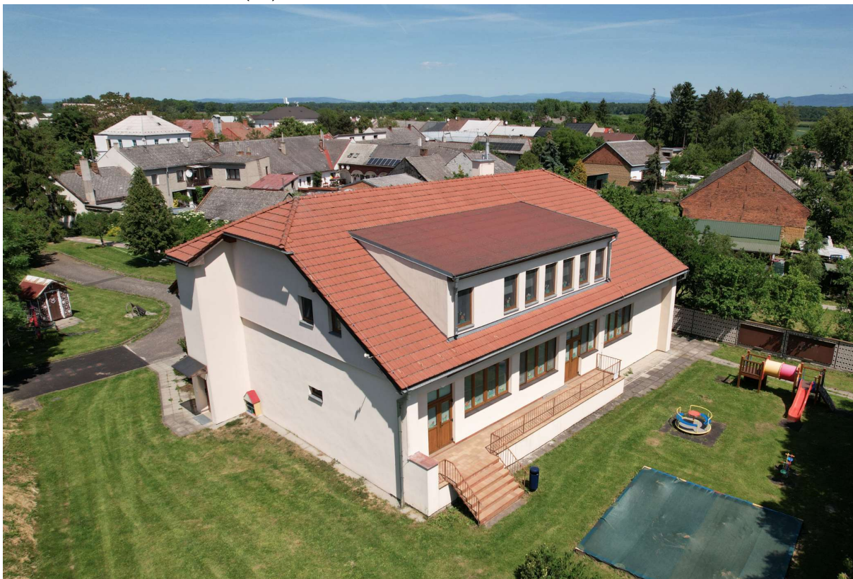
Obrázek č. 2.6.21: Mateřská škola (MŠ) – fotodokumentace z místního šetření
