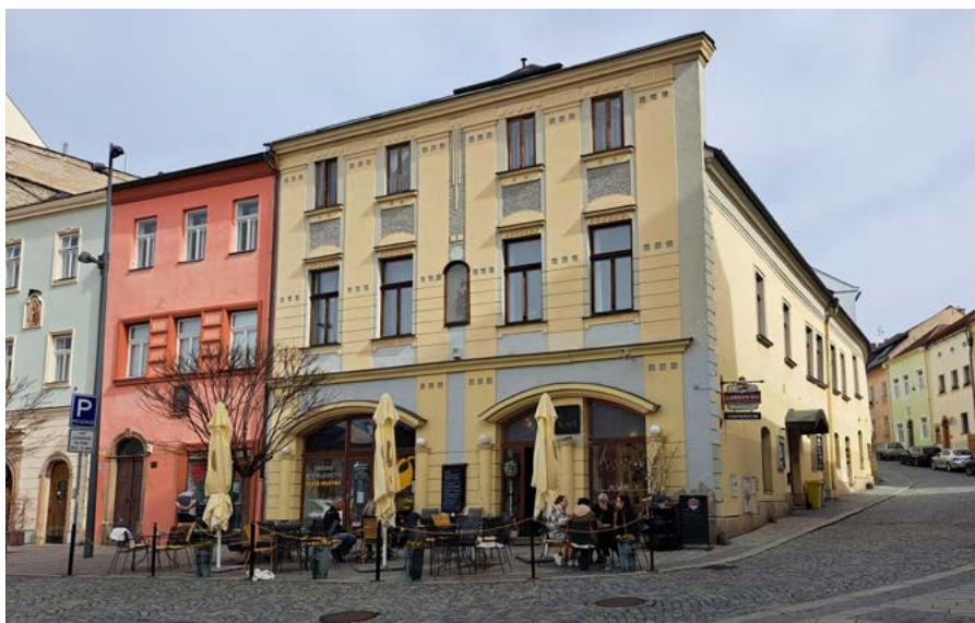
Dům č. 165 na Dolním náměstí a vedle stojící menší dům č. 166, které patřily Skrbenským
