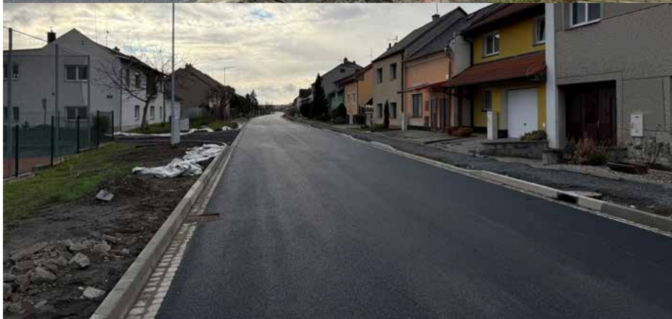
Fotografie nahoře: Pokládka první vrstvy asfaltu 27. 11. 2024. | Fotografie dole: Cesta krátce po položení druhé vrstvy asfaltu, 29. 11. 2024.
