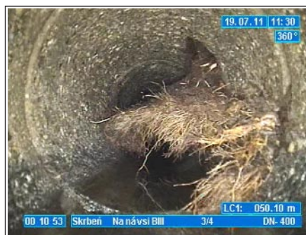
Kořeny kaštanů prorostlé do kanalizace před hospodou NA NÁVSI
