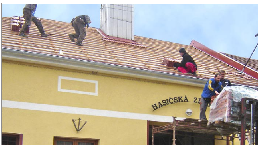
Ačkoliv byla půdní vestavba hasičské zbrojnice zadána stavební firmě, hasiči rovněž přiložili ruku k dílu. Aby mohla být střešní krytina vyměněna co nejdříve, vynosili na střechu nové tašky.
